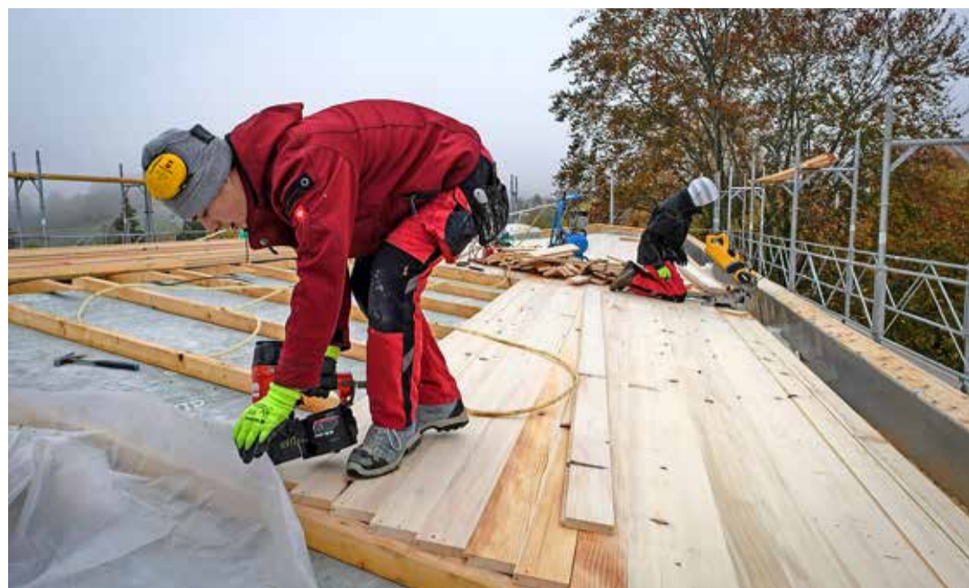
On s'active dans l'immeuble Les Faisans ... Deux ouvriers sont notamment occupés à recouvrir une dalle en bois massif de gravier, ce qui réduira fortement la propagation de bruits entre les différents niveaux. Alain Wicht
