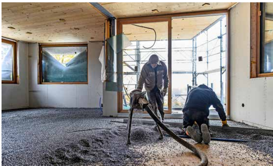
On s'active dans l'immeuble Les Faisans ... Deux ouvriers sont notamment occupés à recouvrir une dalle en bois massif de gravier, ce qui réduira fortement la propagation de bruits entre les différents niveaux. Alain Wicht
